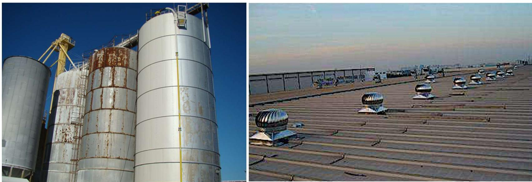
As estruturas acima podem ser revestidas após uma lavagem com baixa pressão. O revestimento **NRX™** reagirá com as áreas galvanizadas, criando fosfato de zinco, bem como o aço corroído, para fornecer excelente proteção contra corrosão a longo prazo.
