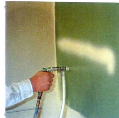
MANTENHA A PISTOLA A 14" DA SUPERFÍCIE A RECOBRIR PRODUZINDO UM LEQUE DE 4" A 5"
