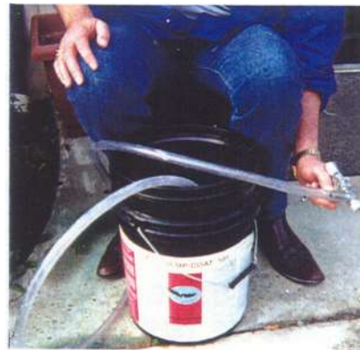
CARREGUE A MANGUEIRA COLOCANDO A PISTOLA NO NÍVEL DO BALDE
