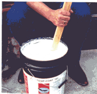
MANTENHA o TEMP-COAT® MISTURADO COM UMA PÁ OU MISTURADOR A MEDIDA QUE APLICA
